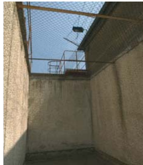
Freigang des Krankenhauses
